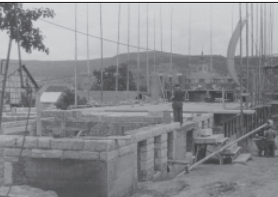
Letzte Vorbereitungen zur Grundsteinlegung
